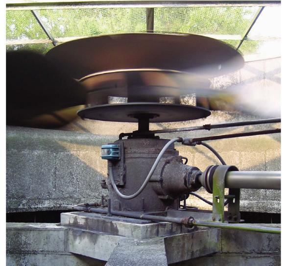
Configuración convencional del accionamiento de un ventilador con una caja reductora montada debajo del ventilador.
